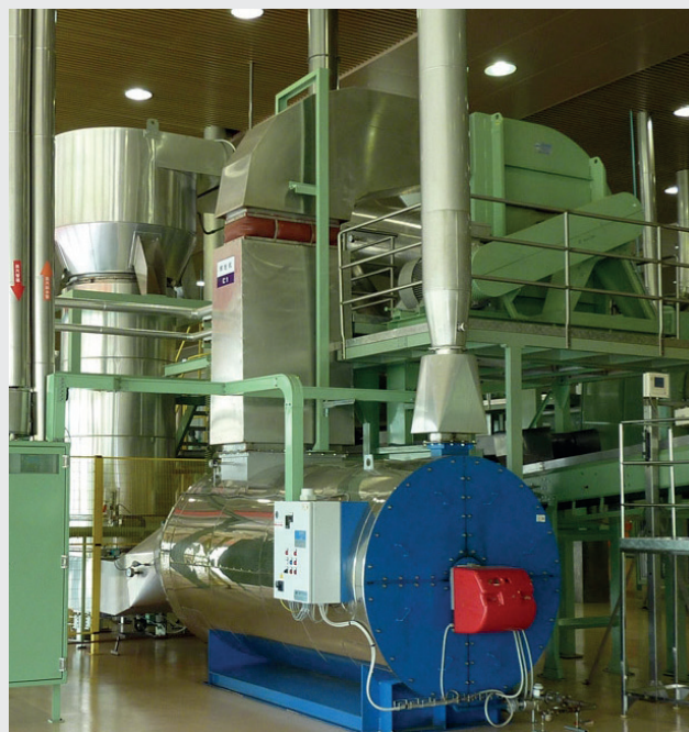
Ogrzewanie powietrza procesowego wysokiej wilgotności za pomocą HTV-N
