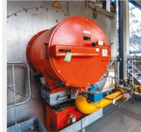
**Rango de potencia:** De 3.5 a 10.5 MW en monobloque (LNTA)
