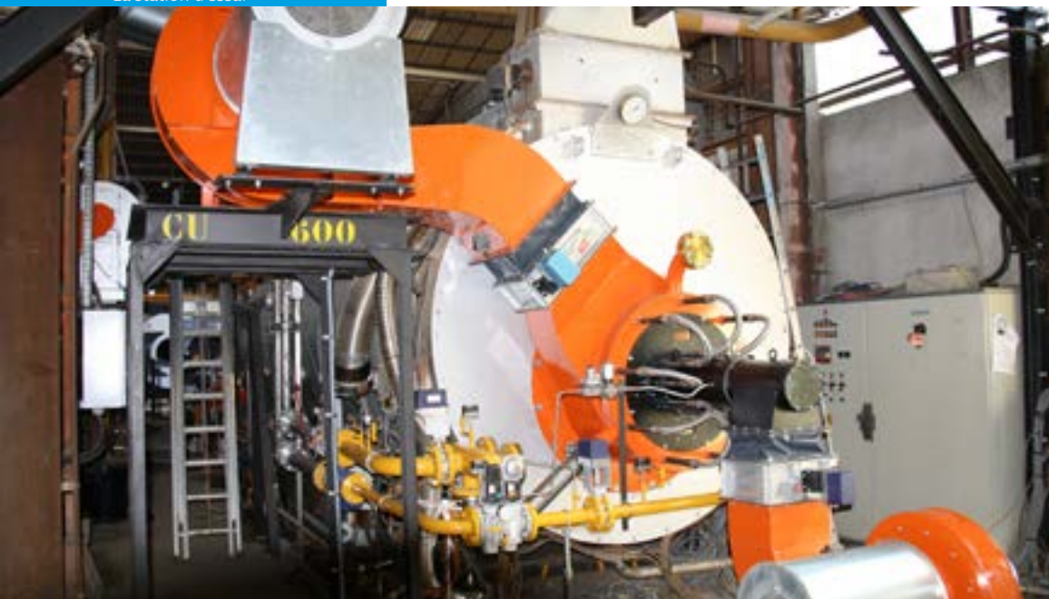
La station d'essai
