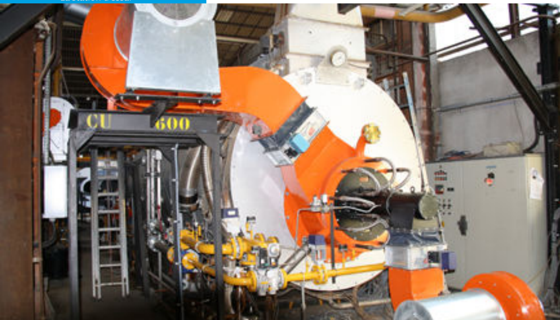
La station d'essai
