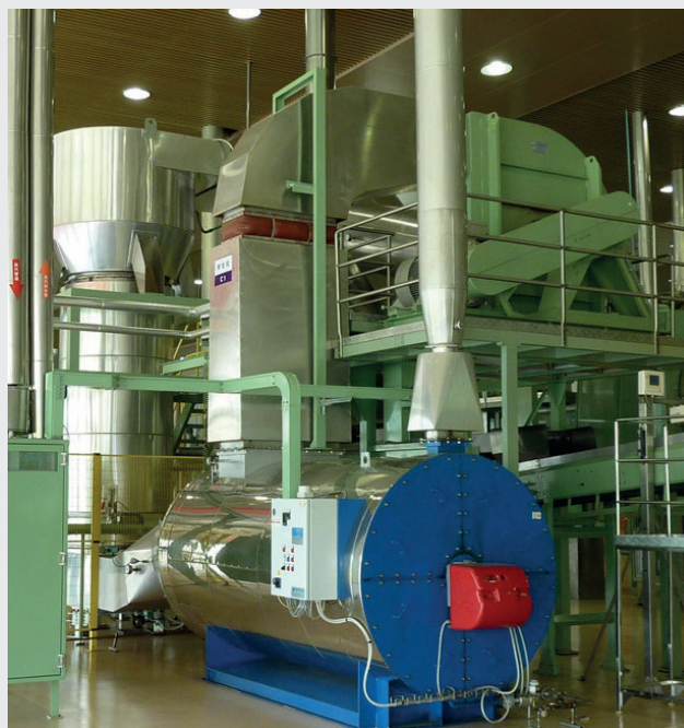
Riscaldamento dell'aria di processo con elevata umidità mediante un HTV-N
