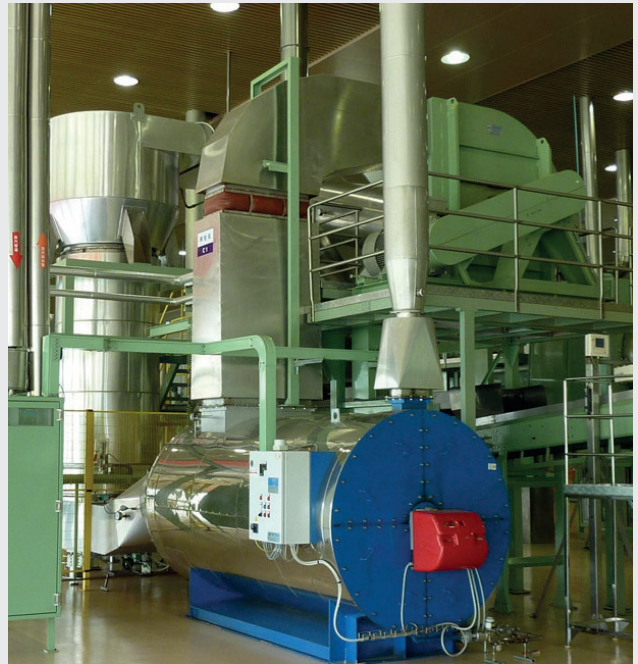
Proces luchtverwarming met een hoge vochtigheid maakt gebruik van HTV-N
